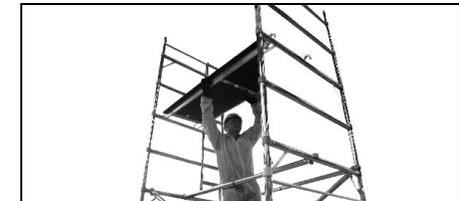
**16** Coloque la plataforma con trampilla a lo largo de la plataforma simple.
