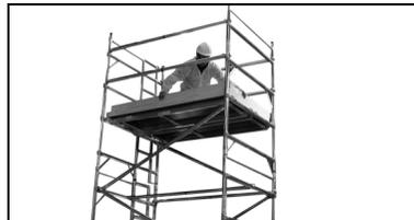
Cuando se utilicen PLATAFORMAS INTERMEDIAS como plataformas de trabajo, colocar una plataforma simple al lado de la plataforma con trampilla y asegúrese de que haya rieles de seguridad y rieles medios en ambos lados de la torre y de que se utilicen las barras de seguridad.
