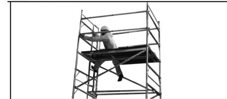
**11** Asegure los estabilizadores tan pronto como sea posible para así aumentar la estabilidad de la torre. Verifique la lista de partes integrales de la torre para asegurarse de que los estabilizadores se encuentren correctamente colocados.
